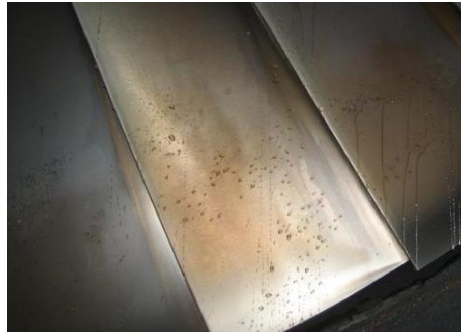
Turbinenschaufeln der letzten Stufe
