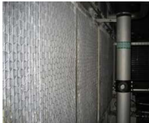
Kühlturmeinbauten vor und nach der Reinigung
